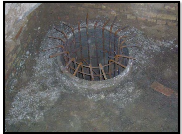
جرای شمع برای رسیدن به خاک سفت
