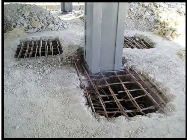
احداث شمع جهت تقویت فونداسیون در محل تقاطع دیوار برشی
