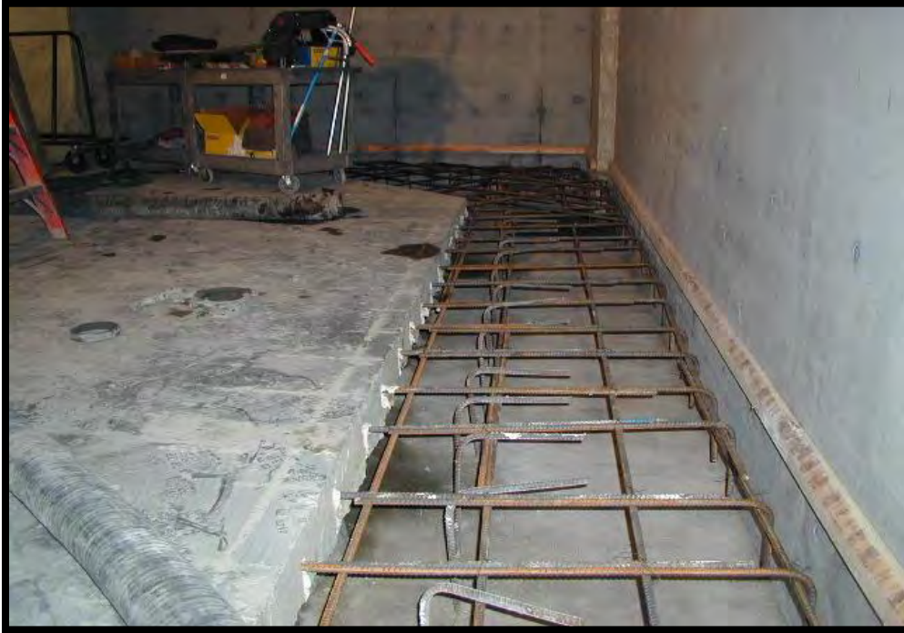
تصویر شماره ۱: تقویت شناژ در مجاورت دیوار برش
