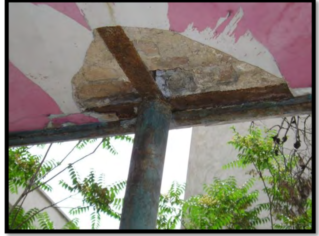
سونداژ اولیه ساختمان جهت شناسائی
