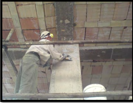
تقویت ستون با الیاف GFRP
