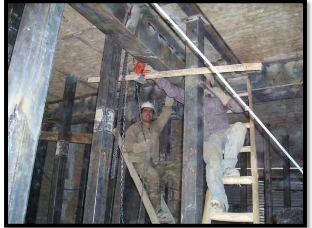
مراحل نصب تیرها با روش های خاص
