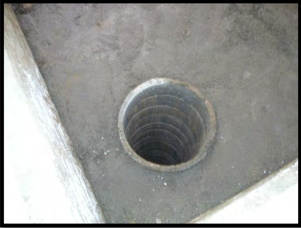
انجام بتن مگر جهت اجرای پی رادیه
