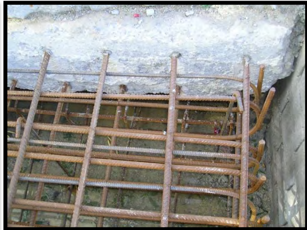
کاشت بولت برای تقویت سطح پی به جهت افزایش تنش
