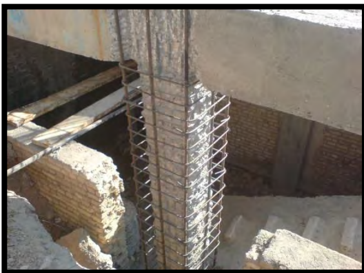
تقویت ستون به روش ژاکت
