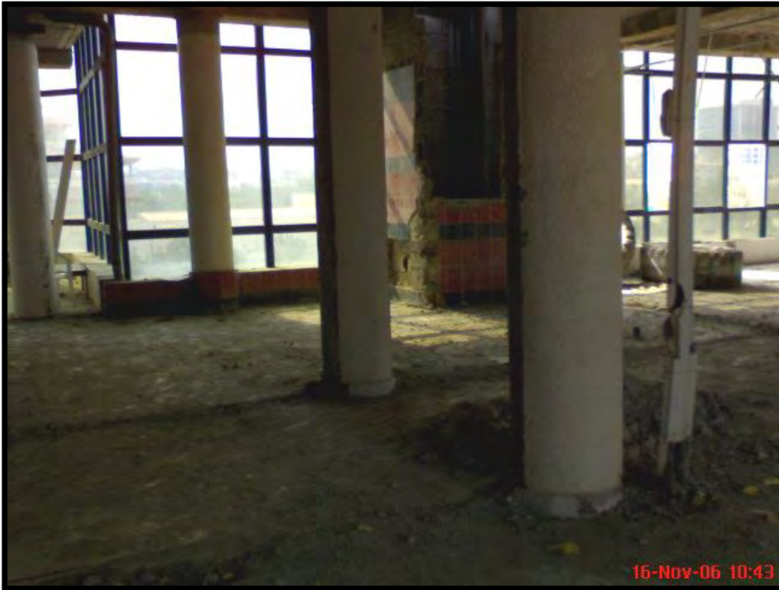
تصویر شماره ۲: مرحله کنترل و تست المانهای سازه ای جهت تهیه نقشه های چون ساخت پروژه ای در کیش
