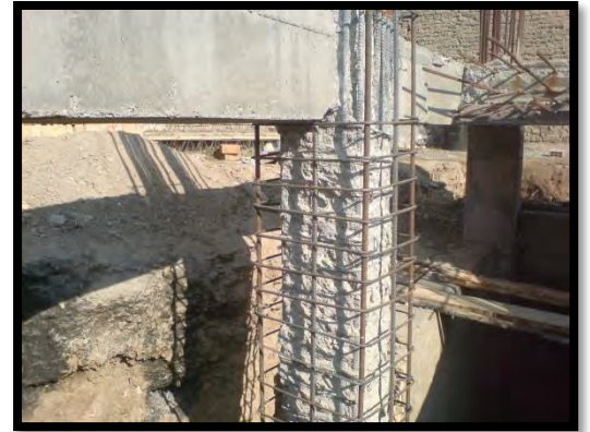
تقویت ستون به روش ژاکت
