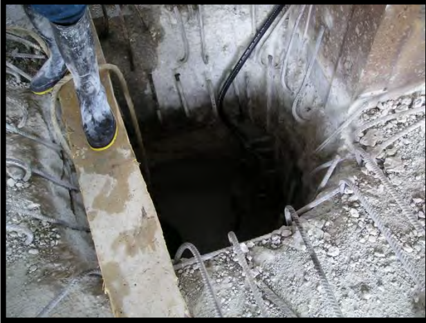
احداث شمع جهت تقویت فونداسیون در محل تقاطع دیوار برشی
