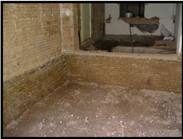
برداشتن خاک دستی جهت اجرای پی رادیه
