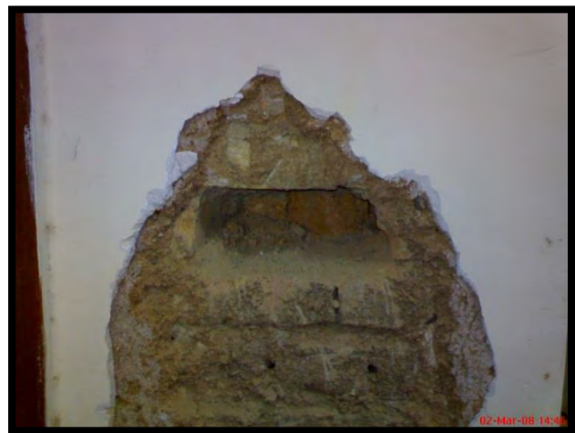
سونداژ اولیه ساختمان جهت شناسائی
