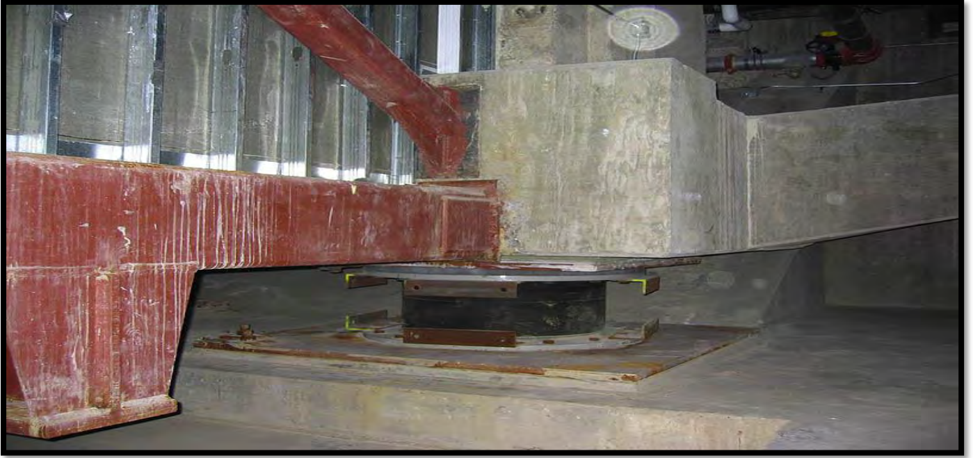
تصویر شماره ۹: BASE ISOLATOR نصب شده به‌مراه تقویت فونداسیون
