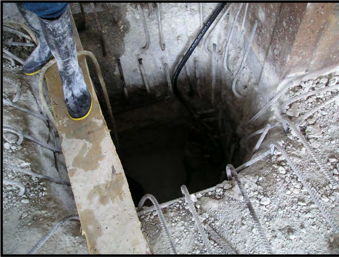
تصویر شماره ۳: تقویت فونداسیون ساختمان اداری ۸ طبقه درکیش با تعدادی شمع
