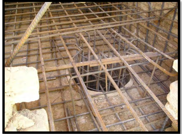
آرماتوربندی شمع و پی رادیه
