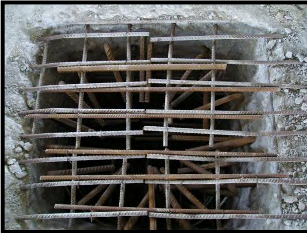
کاشت بولت برای تقویت سطح پی به جهت افزایش تنش
