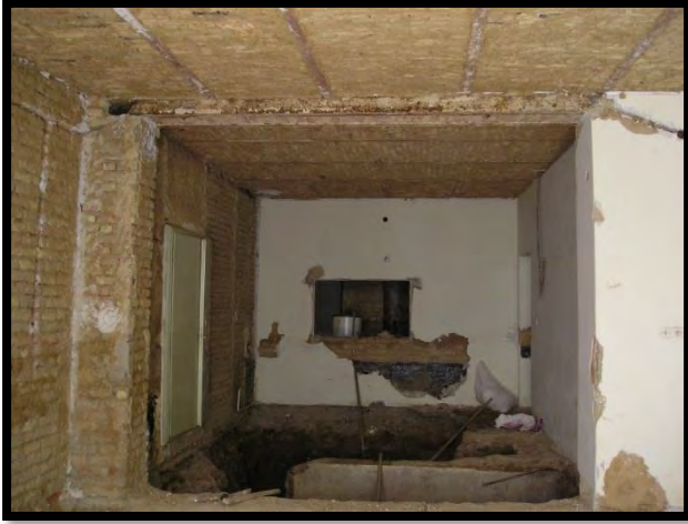
حذف پوشش داخلی برای شناسائی بهتر
