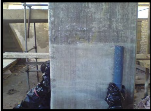
تقویت مقاومت فشاری بادورپیچ کردن
